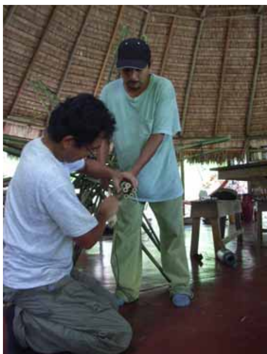
仕上げに綿ロープで端部をしっかり結わえる。この縛り方は 日本の伝統的な縛りを応用し、星籠用に工夫したものである。 まず緩むことはない。
